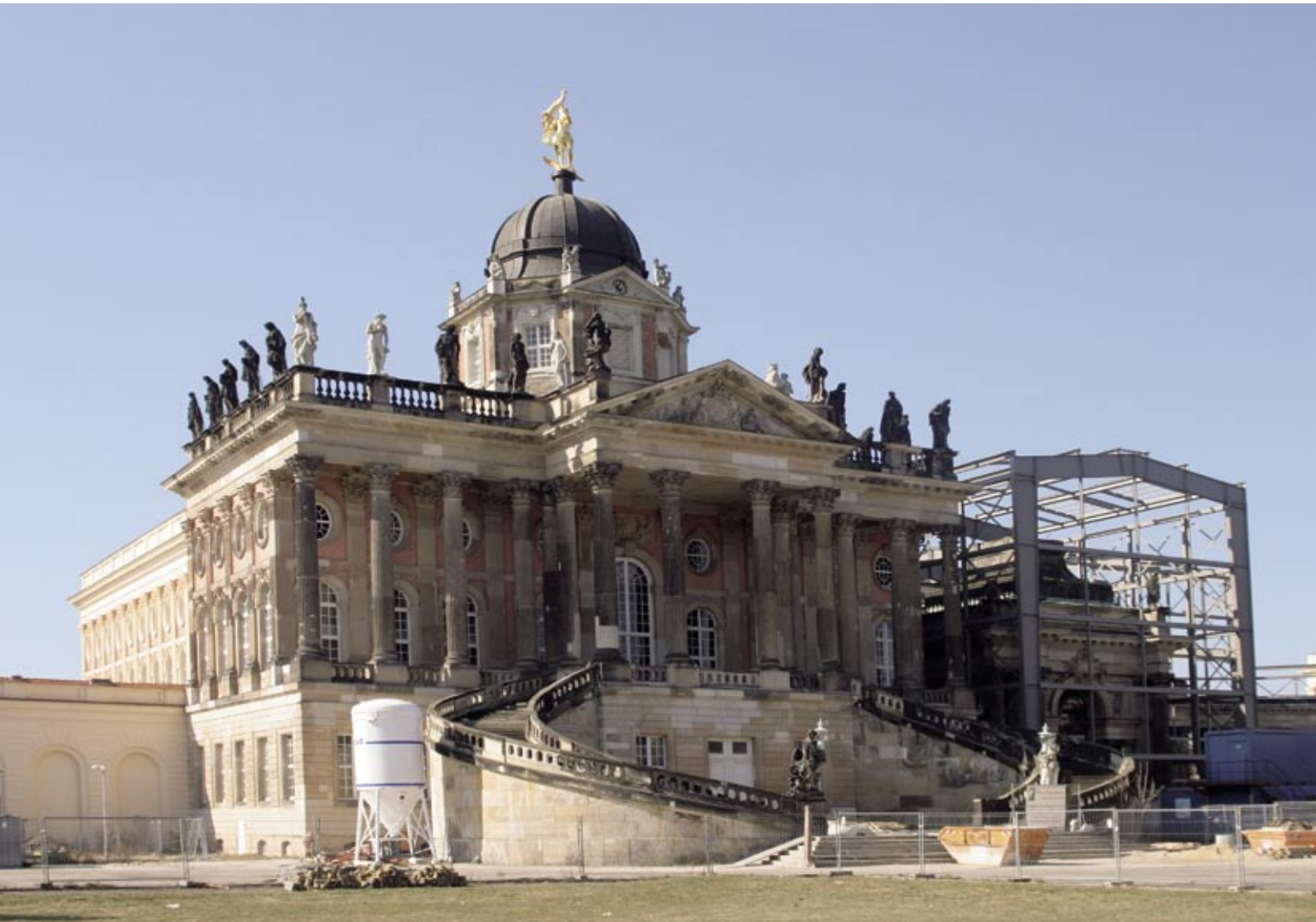
Die Universität Potsdam ist auf vier Campusse verteilt, wovon der Campus Neues Palais wegen seiner historischen Gebäude der beeindruckendste ist.
